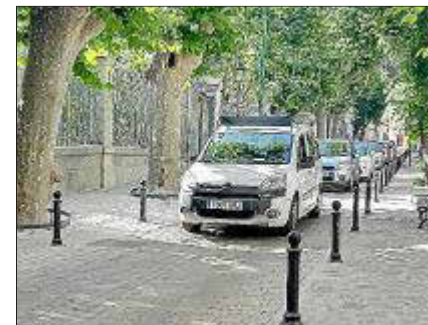
Les canonades estan esclafades i s'haurà d'aixecar part del paviment.
