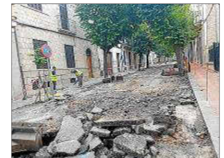
Les obres han començat amb la retirada de tot l'asfalt.
